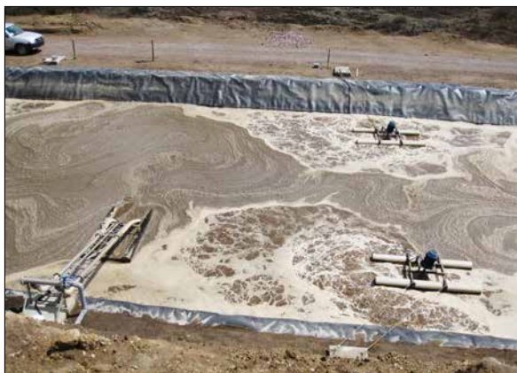
IMAGEN 2. Piscina de tratamiento de lixiviados. Imagen de Fernanda Solíz.
