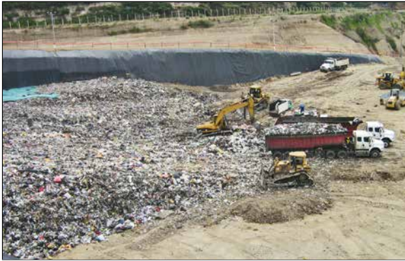
IMAGEN 4. Cubeto de recepción de residuos en El Inga. Imagen de Fernanda Solíz.
